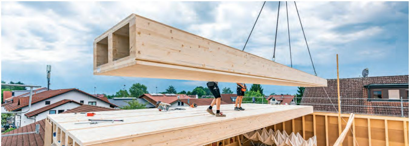
Aufstockung mit CLT BOX Deckenelementen als Einfeldträger mit elf Metern Feldlänge durch Joos Holzbau GmbH am Bodensee (DE).
