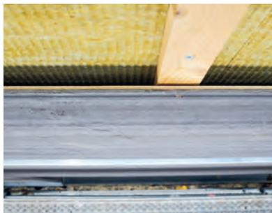
Querschnitt der hinterlüfteten Fassade mit DISSCO-Dämmplatte, Hinterlüftungsraum und Holzbekleidung.
