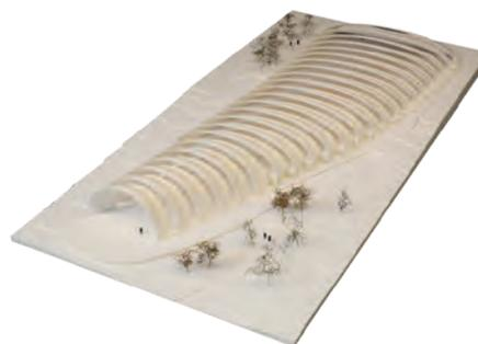
Das Modell zeigt die 23 Holzschalen mit Spannweiten bis 53,7 Meter, die das Dach für die Annen SA in Luxemburg bilden.
